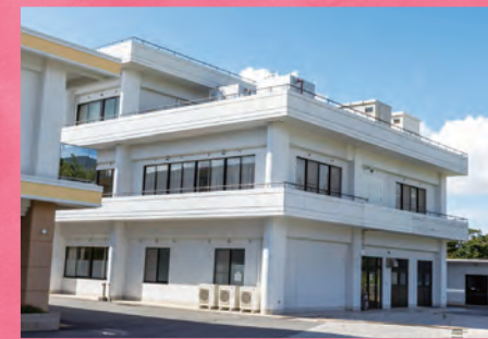
ヒートポンプを導入した北館
